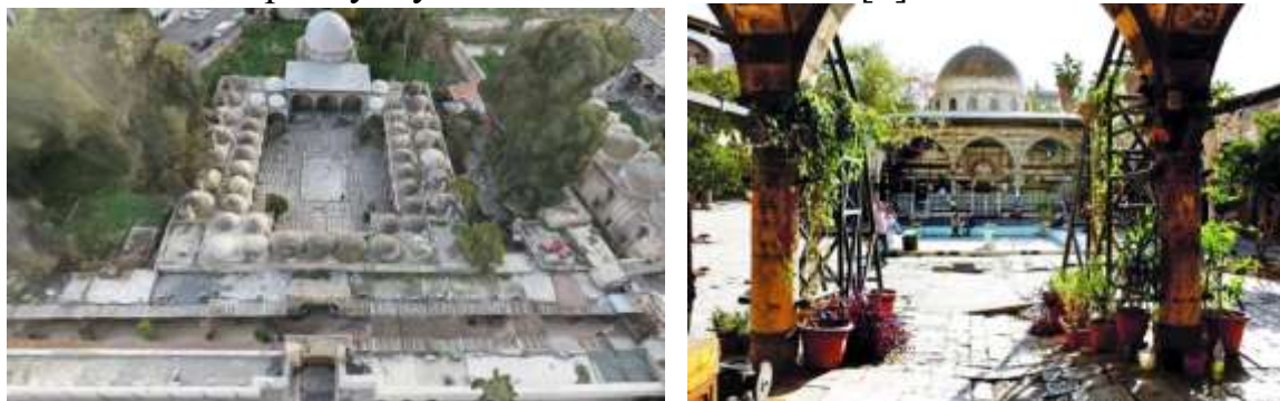
Рис. 2. Аль-Тикья в ходе реставрационных работ.
